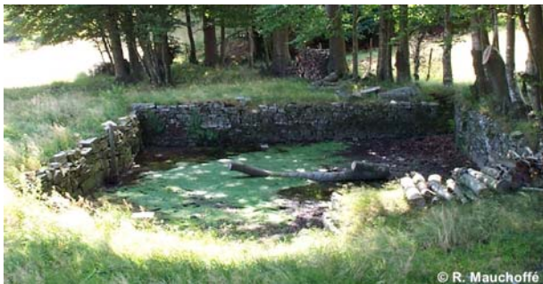
Pesquier en cours de restauration (Tarn).
